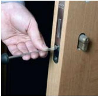
**5** Cilindar je za bravu fiksiran jednim zavrtnjem a to je prvi ispod jezička cilindra. Njega treba odviti tako da izade za otprilike jedan centimetar, tj. dok se ne olabavi i tada ga prstima izvucite još malo, ili ga potpuno izvadite iz otvora.
