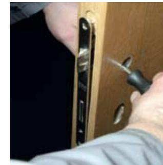
**9** Evo trika za vađenje brave. Ako se čvršće drži u ležištu (a skoro uvek je tako), pogurajte je pomoću odvijača koji ćete provući kroz otvor za osovinu kvake. Drugačije metode (na primer, zavlacenje odvijača uz ivicu čone ploče brave) mogu da oštete vrata.
