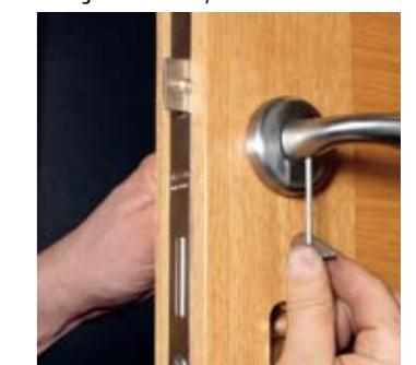
**13** Ključ ostavite u uspravnom položaju da bi Zub pridržao cilindar dok ga učvršćujete zavrtnjem. Ubacite zavrtnj u rupu i zavrtnite ga, a ako ne uspe iz prve, probajte malo da pomerite cilindar da bi zavrtnj „pronašao“ rupu na njemu.
