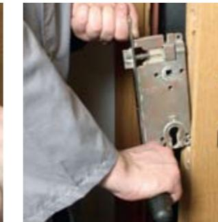
**10** I na kraju demontaže, brava se izvlači iz vrata. Ugradnja počinje stavljanjem brave u ležište i dalje ide redosledom obrnutim od demontaže.
